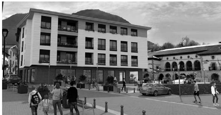
Estankoko eraikin zaharra bota eta etxebizitzak egingo dituzte bertan. ATARIA
