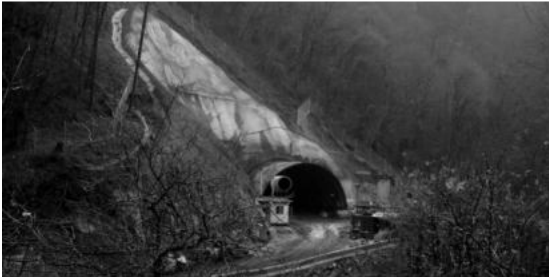
Tolosa-Hernialde zatiko obrak aurrera doaz; irudian, zati horretako tunel baten irteera, Tolosatik Hernialderako bidetik ikusita. E. MAIZ
