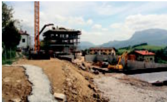
Etxebizitzaren eta balio anitzeko eraikinaren obrak, atzo. I. GARCIA
