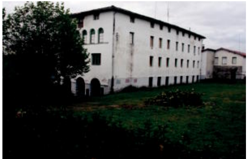
Eskolapioen eraikina eraitsiko dute eta ondoan egingo dituzte etxebizitza berriak eta balioanitzeko eraikina. I. GARCIA
