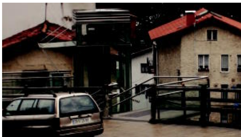
Julian Gaiarre kale inguruan obra ugari egin dituzte; baranda berriak jarri dituzte, lurrak konpondu dituzte... I. TERRADILLOS
