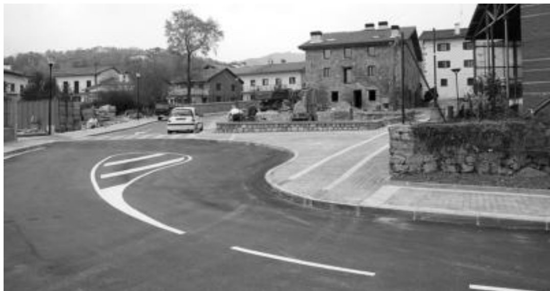
Herrigunea inguratzen duen errepidearen zati bat eta parke berriaren obrak egiten. I. GARCIA
