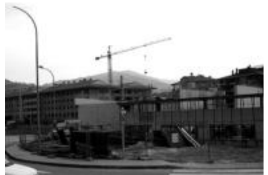
Tolargiko subestazioa ari dira egiten San Esteban auzoan. J.SAIZAR
