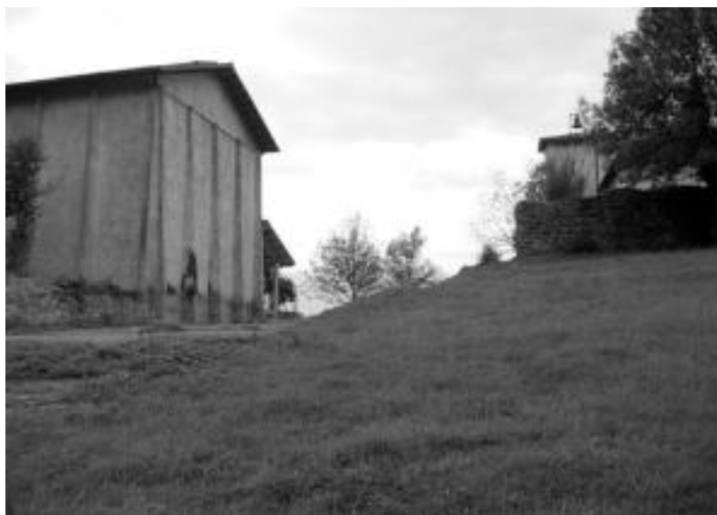
Eskola berria Santa Barbara basilizaren eta pilotalekuaren atzekaldean eraikiko dute. O.ESKIXABEL
