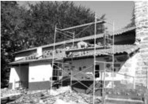
Santa Krutz ermitan langileak teila berritzen. JAIONE ASTIBIA
