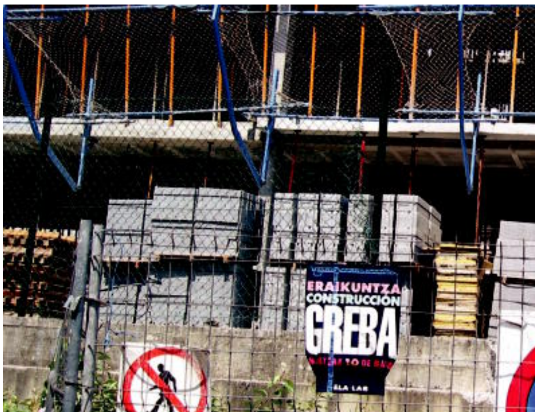
Eraikuntza greba dela-eta Tolosako obra bat geldirik, maiatzaren 10etik grebarako deialdia egiten duen kartela aurrealdean duela. JOXEMI SAIZAR
