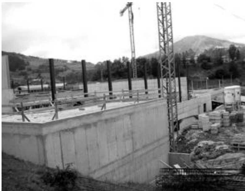
Usabalgo kirolguneko lanak, geldirik, eraikuntza greba dela eta. LEIRE MONTES
